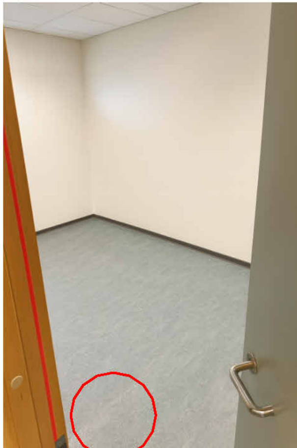
Eksempel på skjøt mellom eksisterende og ny linoleum
